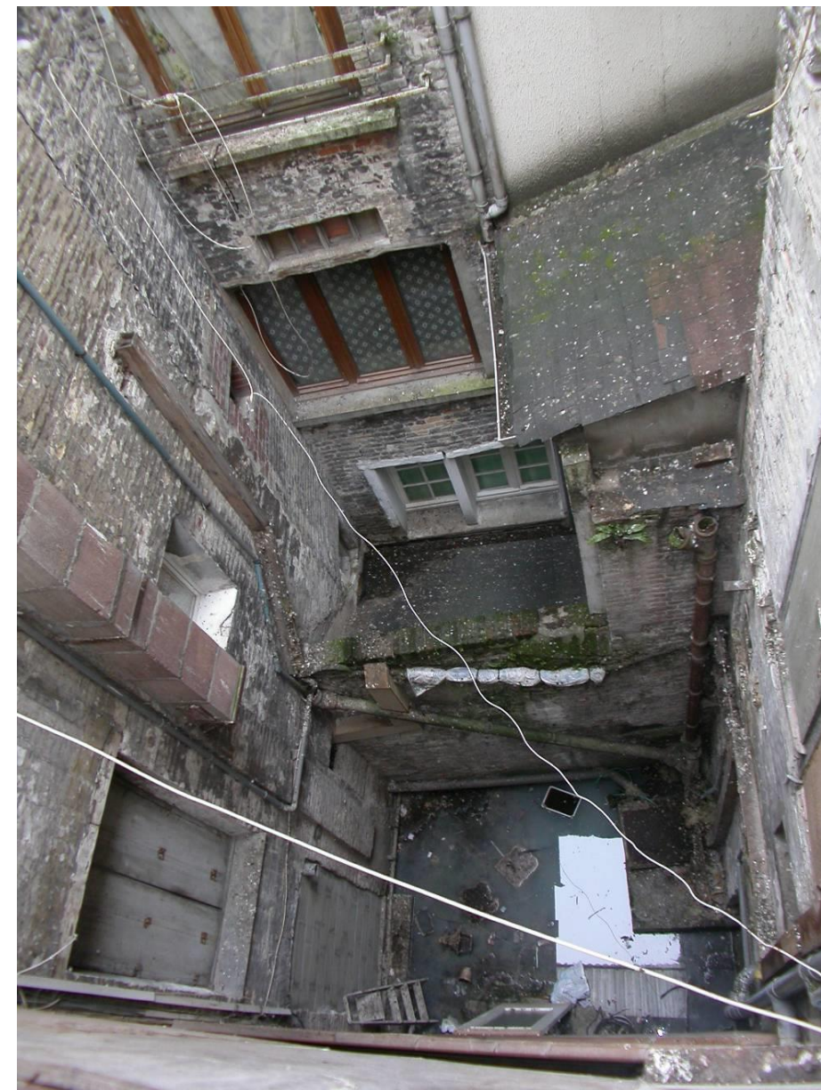
Un cœur d'îlot, derrière la plus belle façade sur le port...
