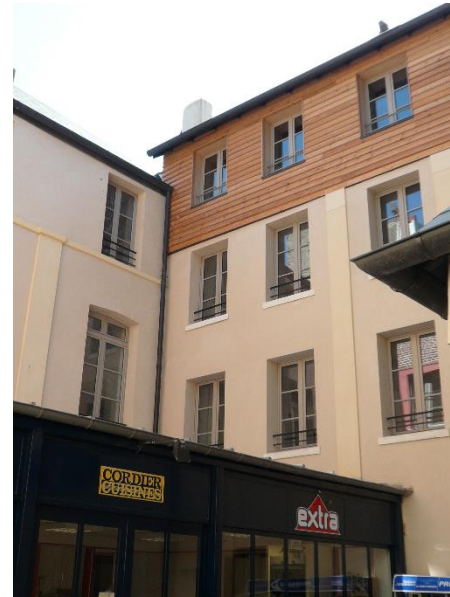
Après travaux : local commercial partiellement conservé sur cour, en lien avec le commerce sur rue
