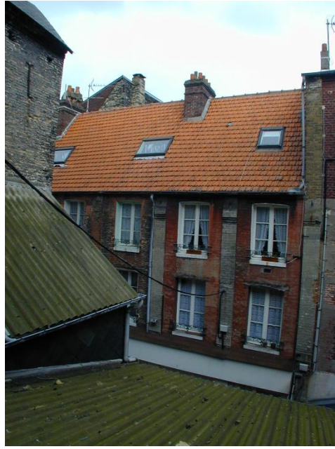
Avant travaux : locaux à démolir partiellement
