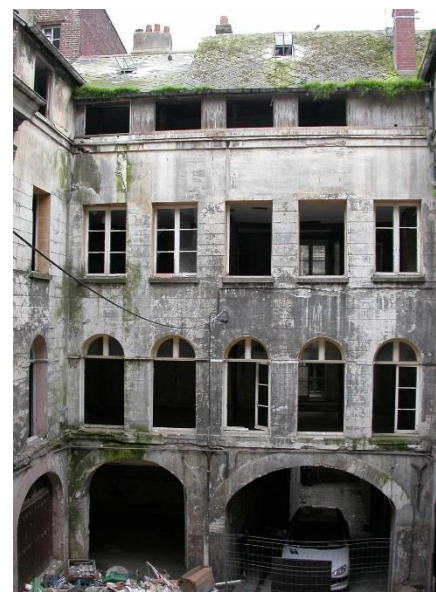
Bâtiment donnant sur rue : avant travaux
