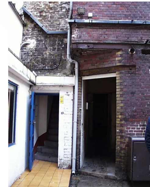
Avant travaux : Accès mutualisé donnant accès à la cour du 45
