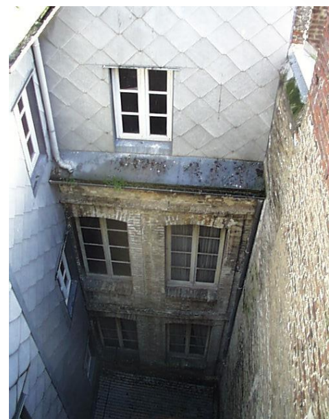
Avant travaux : cour
