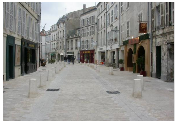
Doc 3 Rue Saint-Jean du Pérot avant/après © Communauté d'Agglomération de La Rochelle
