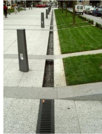
Doc 3 Gestion aérienne de l'eau par une canalisation qui ressort © Urban-Eco Scop
