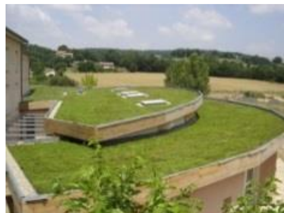
Doc 2 Végétalisation extensive © Adivet
