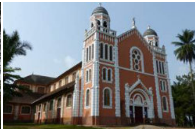
Façade restaurée de l'Eglise Notre Dame des Sept Douleurs d'Akono.
