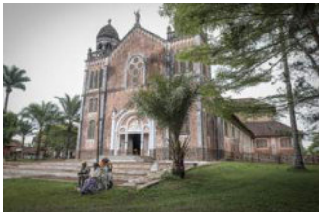
Eglise Notre Dame des Sept Douleurs d'Akono avant restauration.
