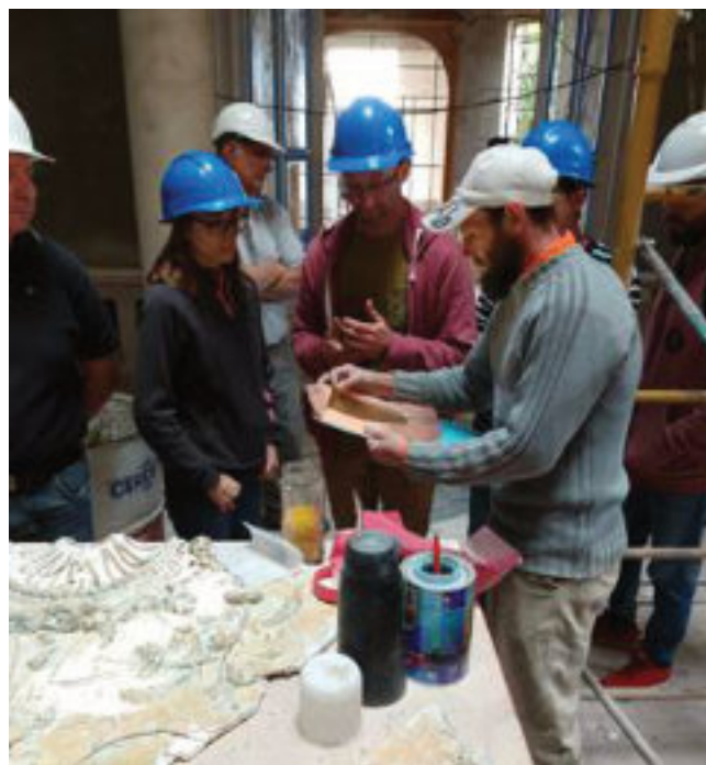
Visite de chantier.
