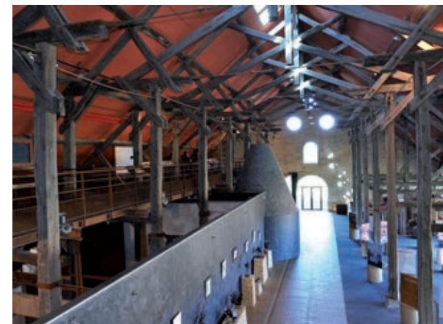
La Halle à charbons de Grossouvre, ouverte au public en 2009 sous le nom d'Espace Métal, dans le PAH Loire Val d'Aubois est l'un des points d'ancrage du réseau de l' European Route of Industrial Heritage en France.
