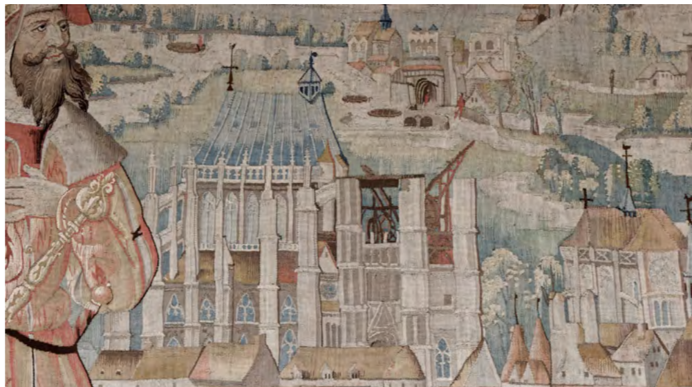
Détail de la tapisserie « Fondation de la ville de Belges », tenture de l'histoire des Gaules, trésor de la cathédrale, 1 ère moitié du XVI e siècle. On distingue dans la cathédrale en construction une roue de levage, ou écureuil (CAOA)
