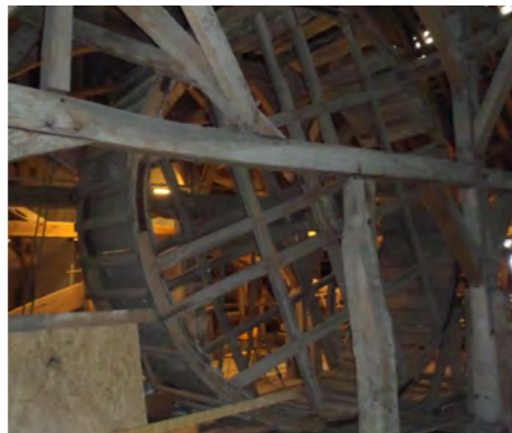
Roue de levage, ou écureuil, installée dans les combles du transept (SAM)
