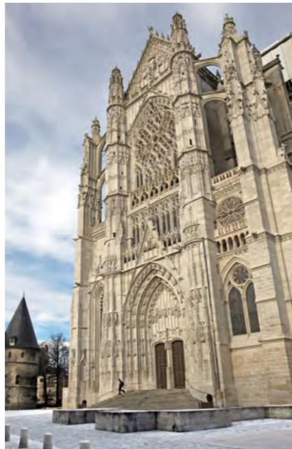
Pignon et portail du transept sud du XVI e siècle avec, au premier plan, la restitution des vestiges de la Tour César découverts sur le parvis en 2008 (BVS)
