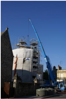
La Tour de la Bridole en cours de restauration, cl. Ville de Vitré
