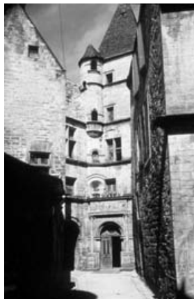
Hôtel de Maleville, avant travaux Collection musée de Sarlat
