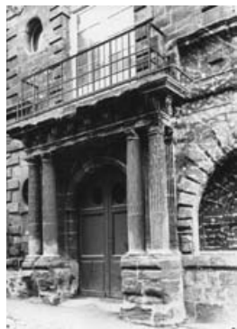
Portail d'entrée, avant travaux Hôtel de ville, rue Fénelon. Collection musée de Sarlat
