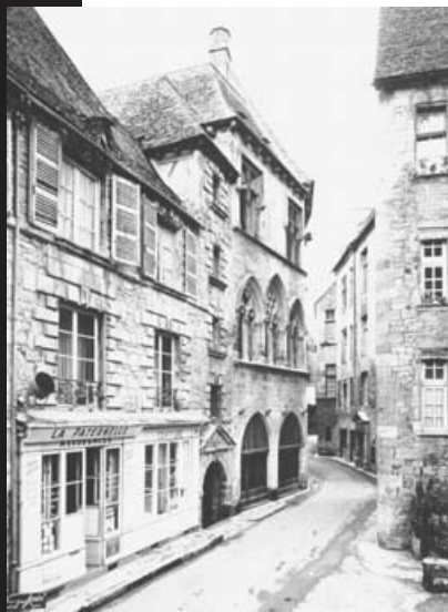
L'hôtel Plamon après restauration Photographie Guy Rivière, 1975
