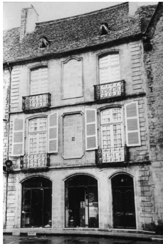
Façade après travaux
