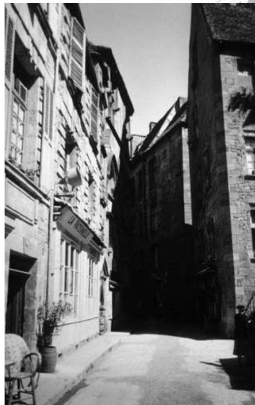
Rue des Consuls après travaux
