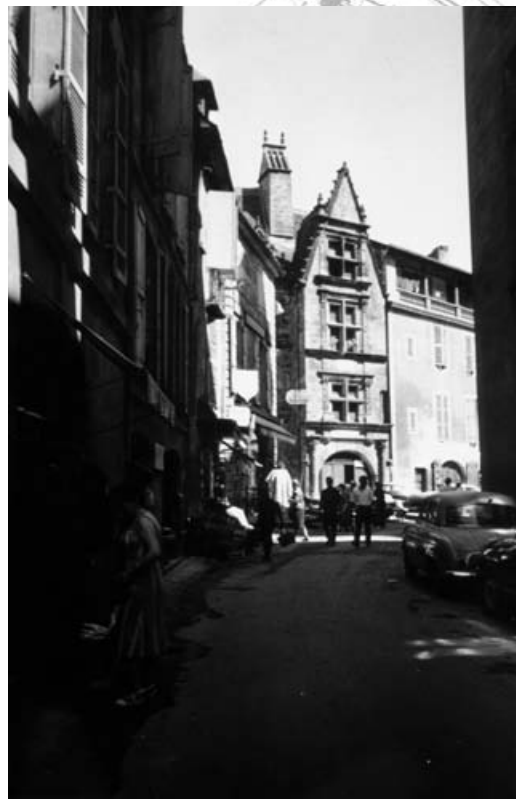
Rue Tourny après travaux
