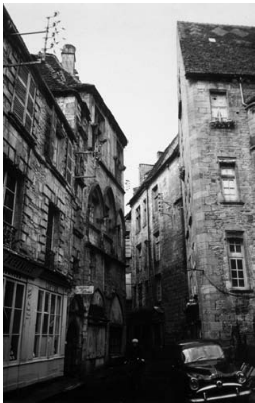
Rue des Consuls avant travaux
