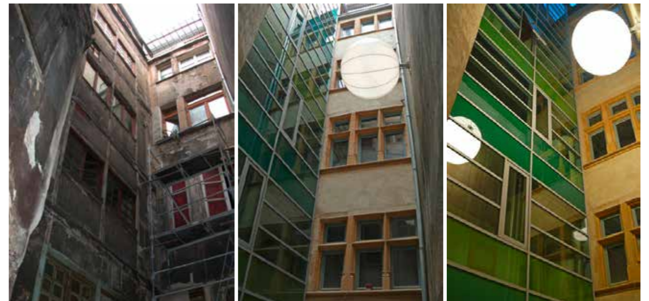
3 Façade avant et après travaux © DETRY & LEVY
