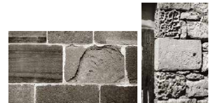
3 Altérations de l'aspect de la pierre : alvéolisation provoquant l'action des bactéries © Laurent COIGNET
