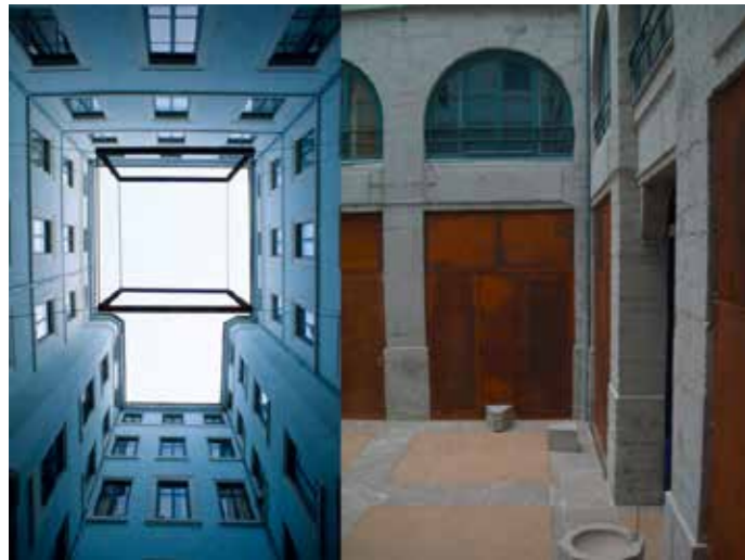
2 Le cube vu de dessous et les portes en acier Corten © DETRY & LEVY
