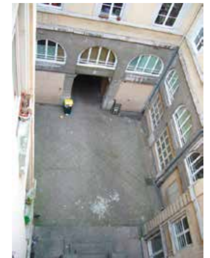
1 La cour avant travaux © DETRY & LEVY
