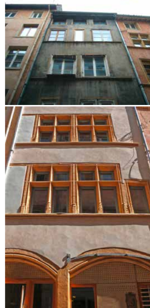
④ Façade avant et après travaux © DETRY & LEVY
