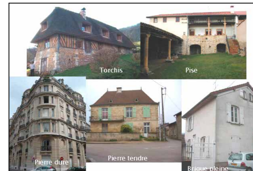
② Typologie des parois anciennes © CETE de l'Est
