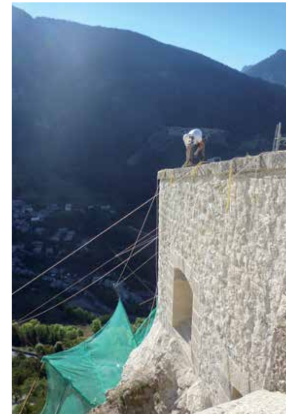
Travaux de restauration au fort des Salettes, Briançon - Réseau Vauban
