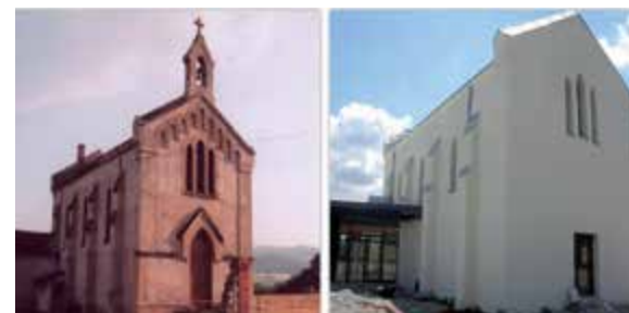
Chapelle avant et après isolation
