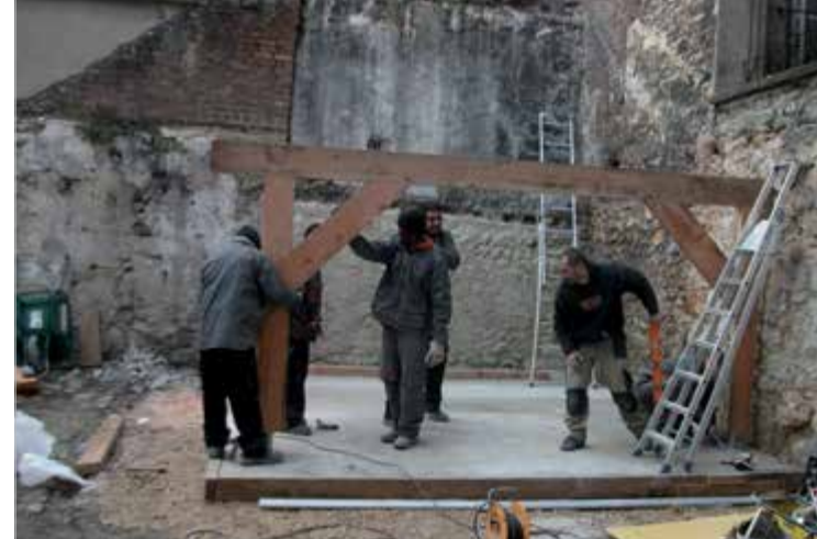
Chantier école de l'îlot Cygne
