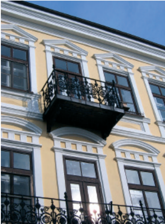
Le détail d'une façade de la période de la Libération (1878-1920)
