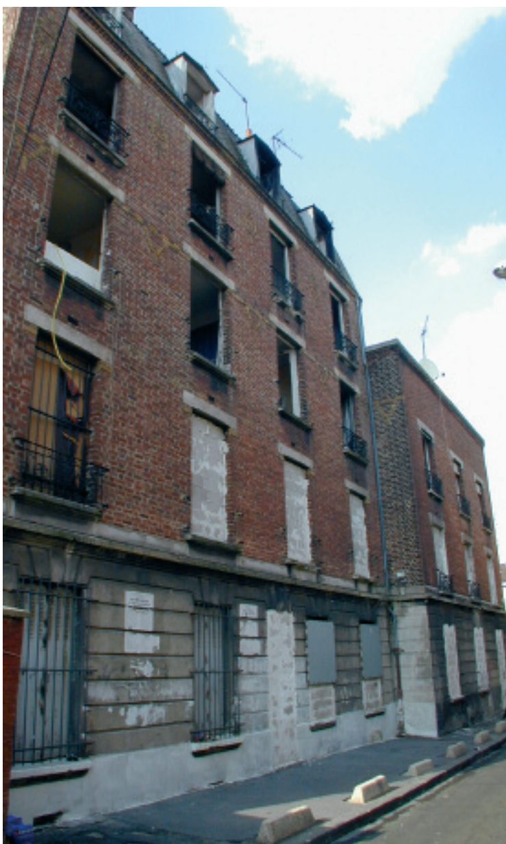
La rue Biron avant travaux
