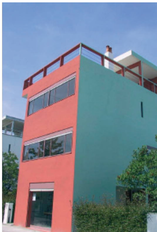
Façade nord est de la maison gratte-ciel, 4 rue Le Corbusier
