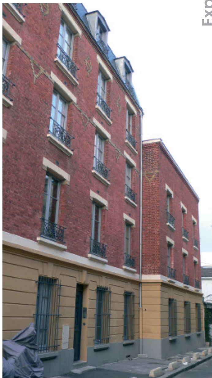
La rue Biron après travaux
