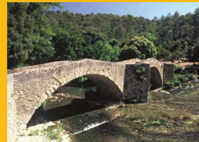
↑ Le vieux pont de Vins.
