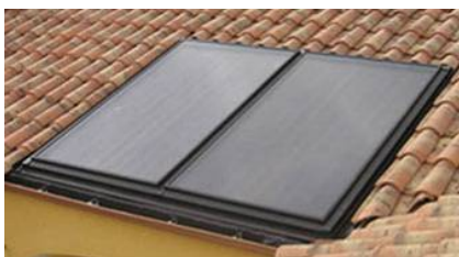
Exemple de panneaux solaires thermiques
