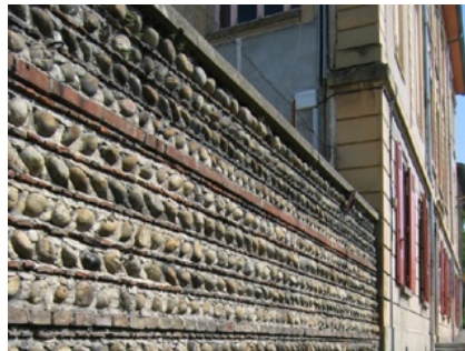
Détail sur un mur de galets roulés
