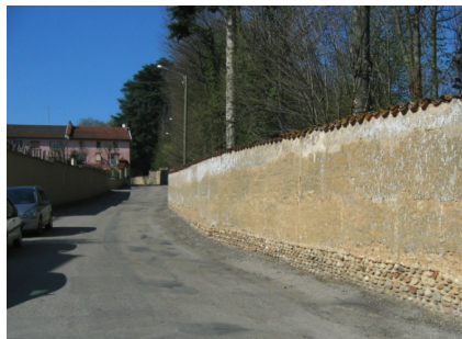
Mur de clôture du parc d'Allivet : Semelle en galets + pisé
