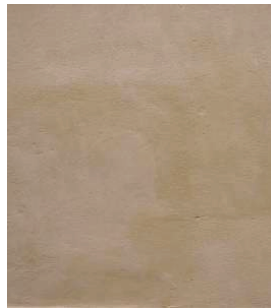
enduit lissé à la truelle
