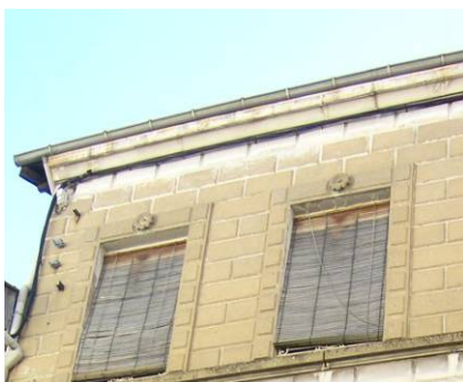
Corniche en ciment moulé
