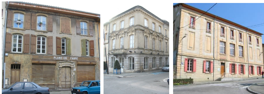
Exemples d'édifices enduits. Pierre de taille en soubassement ou en encadrement, décors en ciment moulés, réhaussent la composition.
