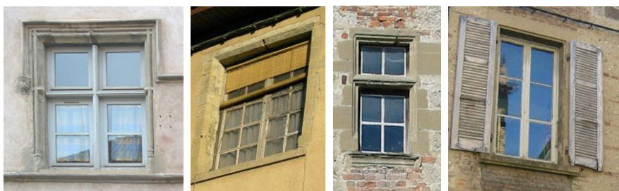
Menuiseries avec proportions de carreaux adéquates à la forme des baies
