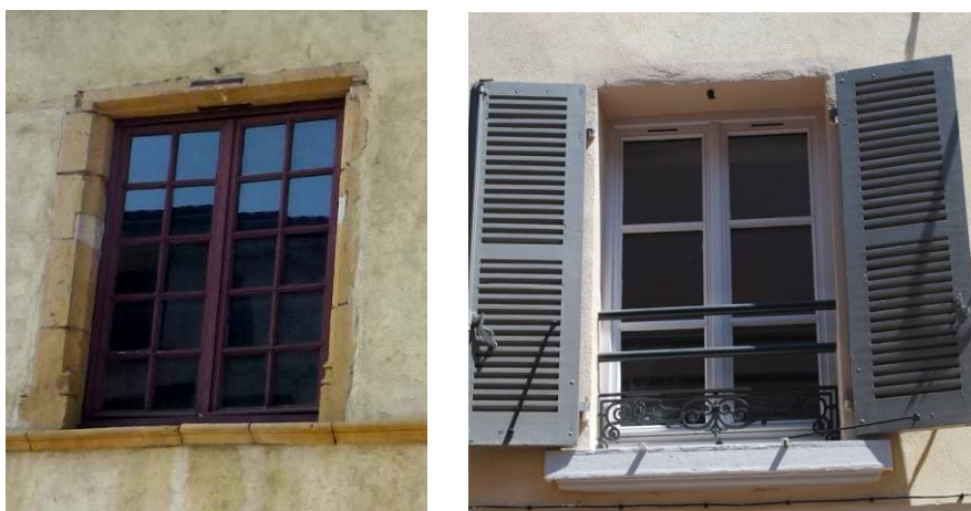
Menuiseries avec proportions de carreaux adéquates à la forme des baies
