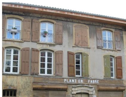
Dépassée de toiture à bandeau
