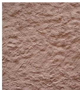
enduit jetée à la truelle
