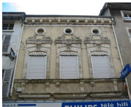
Corniche à consoles en pierre de taille
