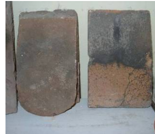
Tuiles plates à crochets
