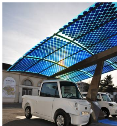
« Ombrières » photovoltaïques sur un parking
