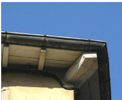
Dépassée de toiture solives et volige apparentes
