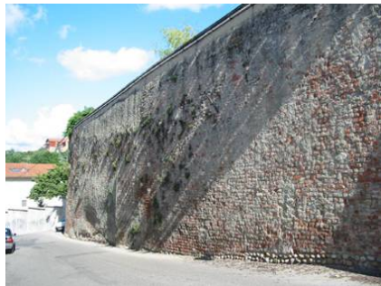
Soutènement sud du château en « savoyardeaux »
