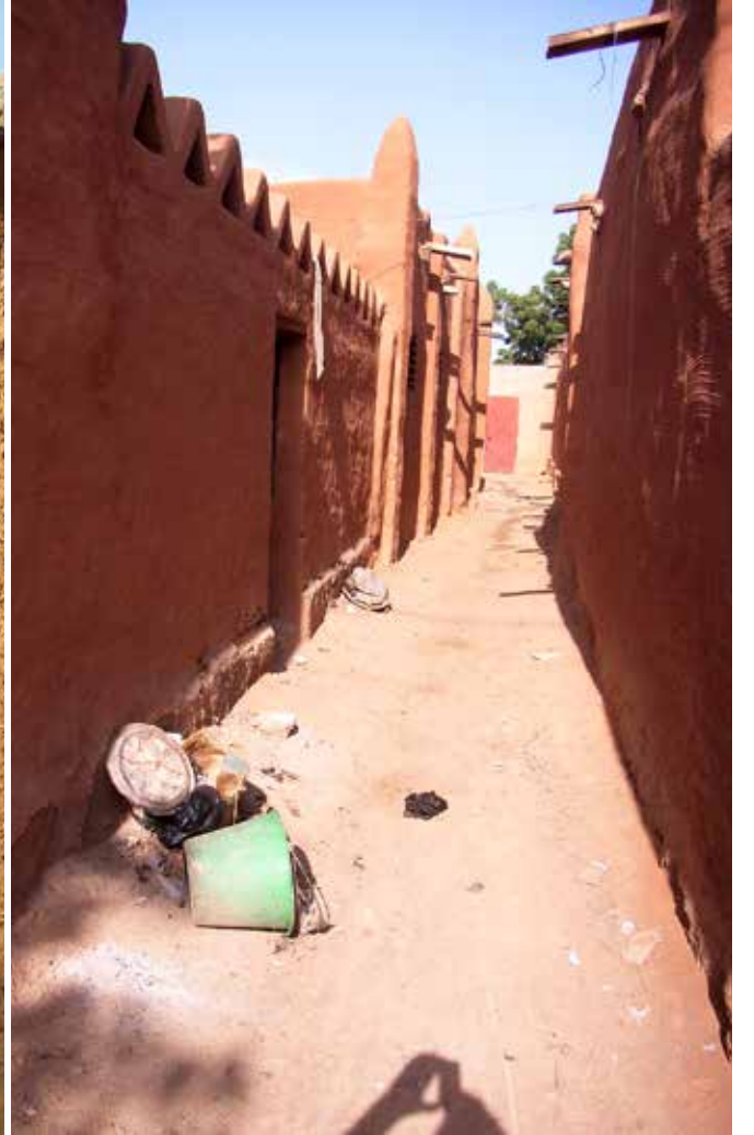
Ruelle avant travaux, en décembre 2006 et après travaux, en mars 2007.
