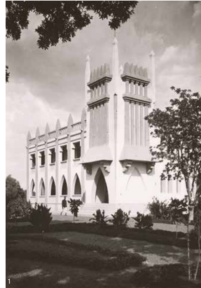
1. La Résidence de Ségo, mise en chantier en 1928.
