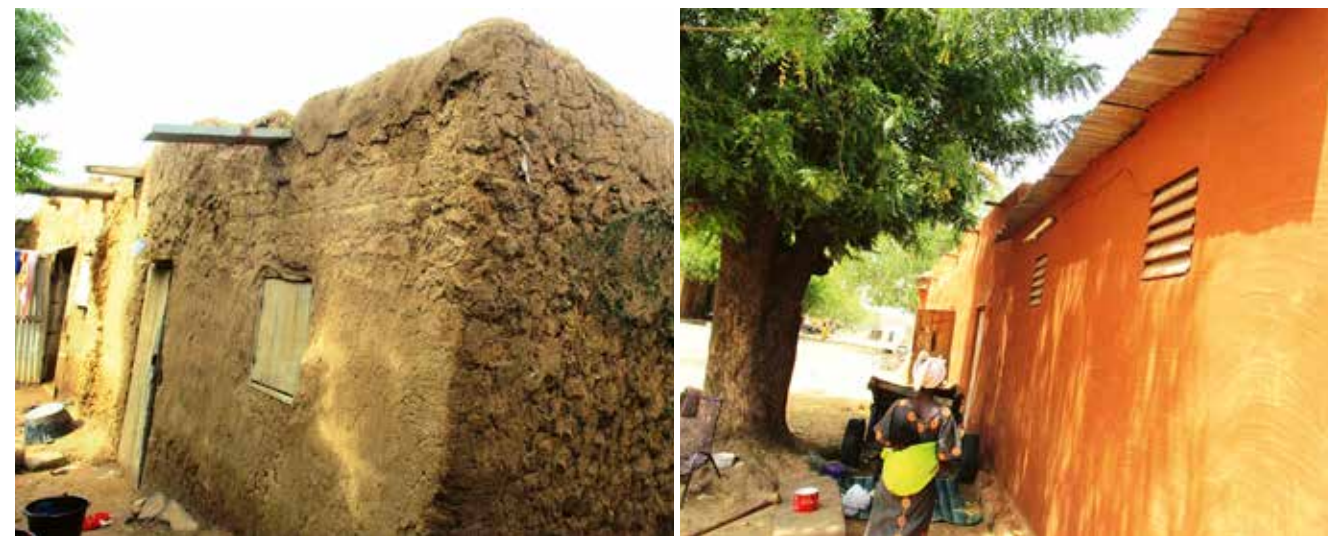
Concession avant travaux, en août 2016 et après travaux, en mars 2017.
