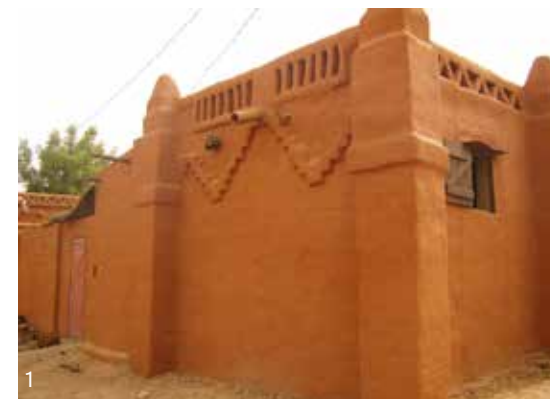
1. Concession restaurée du quartier Somono.
