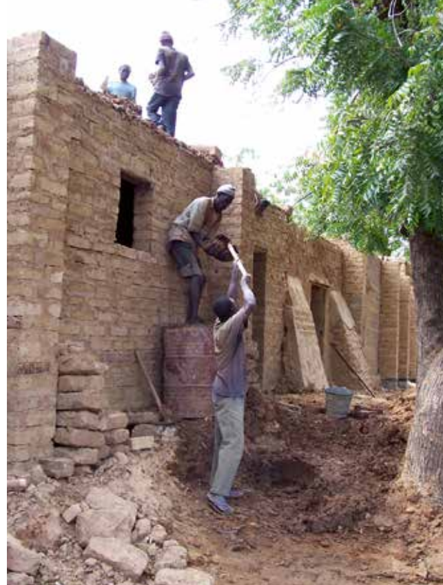
Le chantier de restauration.
