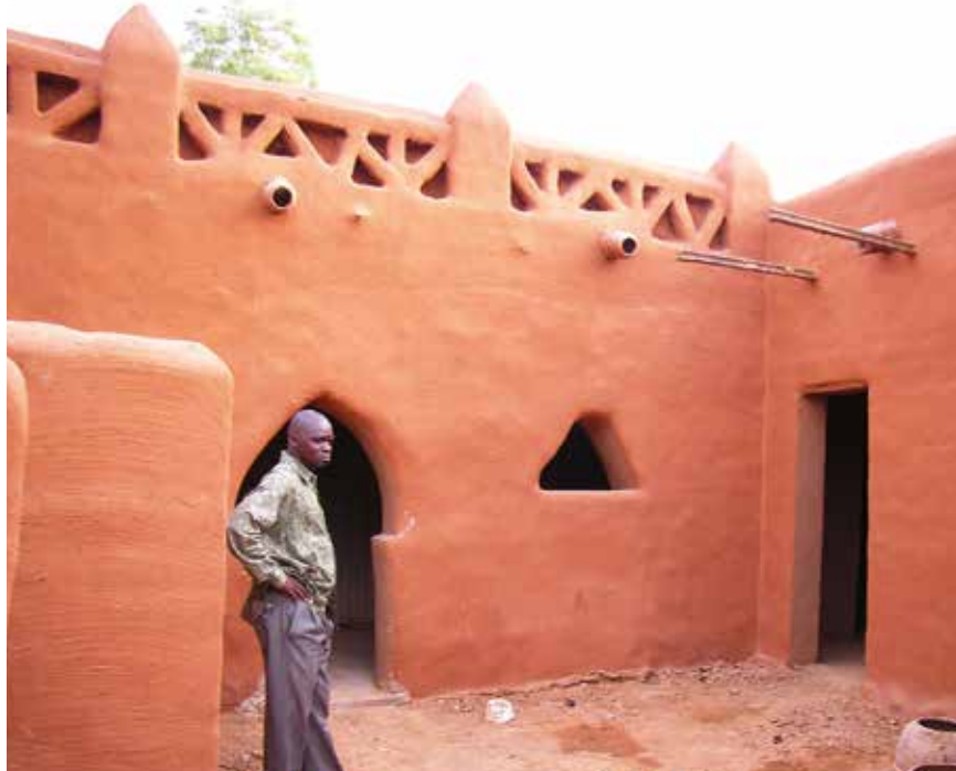
Concession avant travaux, en décembre 2006 et après travaux, en mars 2007.
