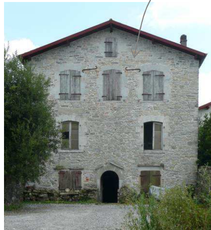
Façade arrière non-enduite
