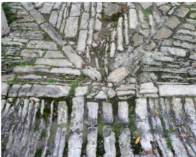
Motif de pavage des seuils et fils d'eau
