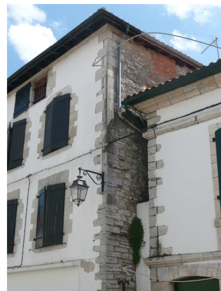
Façade avant enduite
