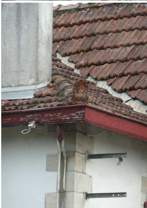
Couverture de tuiles mécaniques et détail d'arétier Détail rives de toit
