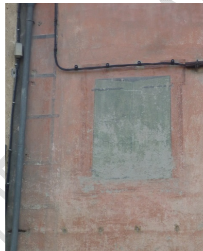
Exemples de décors peints : bossages d'angle , fausse baie et encadrements de baies à crossettes. On note que les encadrements sont soulignés par un liseret ou par un ombrage. Ces décors sont réalisés à l'aide de badigeons de chaux colorés très variés.
