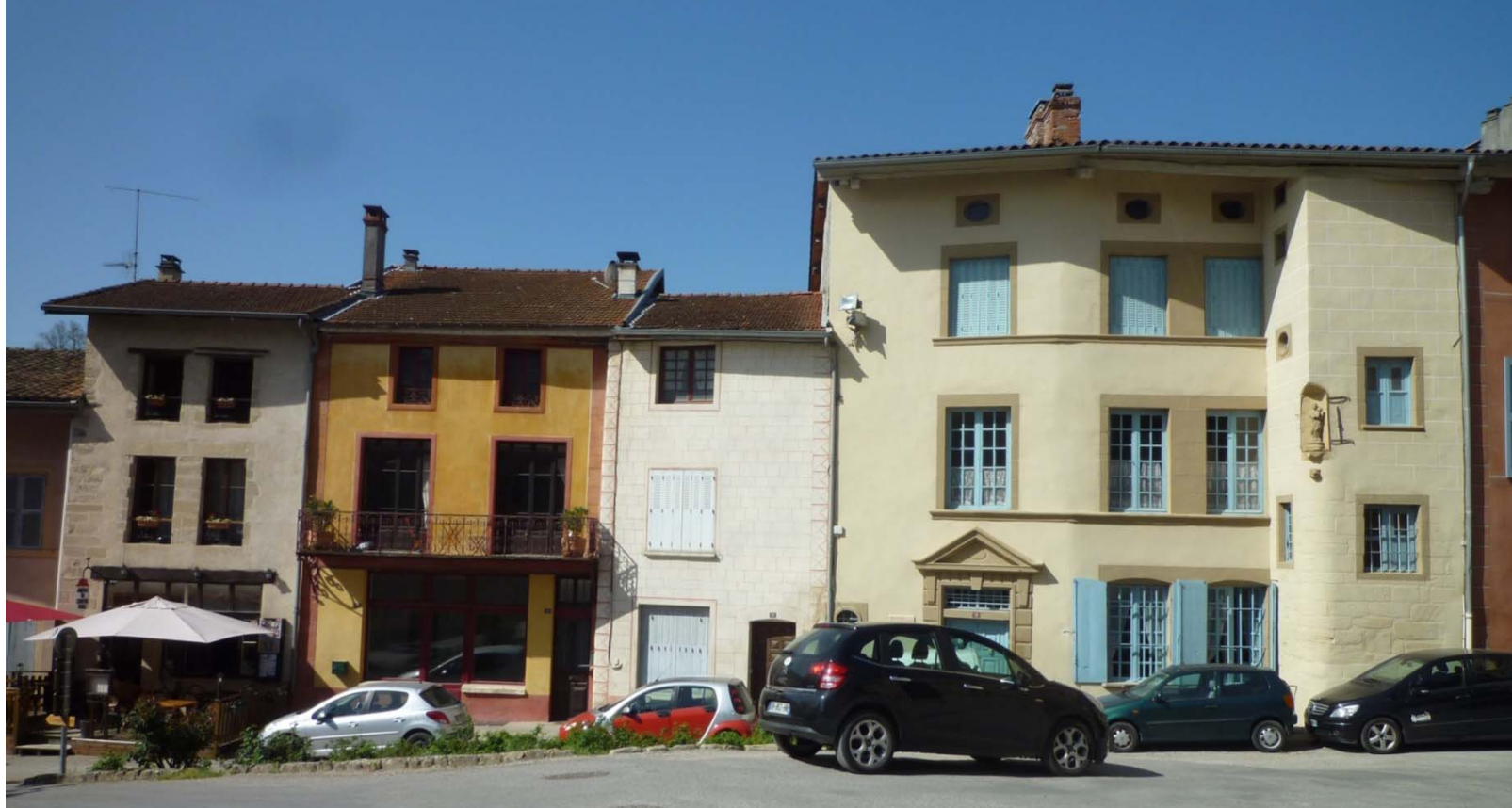
Exemple de façades avec décors de badigeons de chaux colorés
