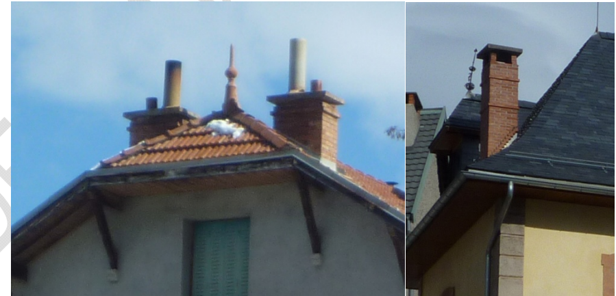
Toiture à demi-croupe, couverture en tuiles mécaniques
