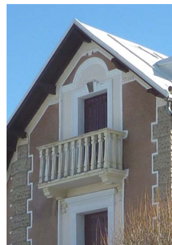
Balcon début XXe en pierre sur consoles, garde-corps à balustres
