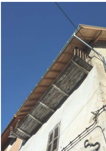
Balcon XIXe en bois sur consoles, garde-corps en bois à barreaudage vertical simple en bois
