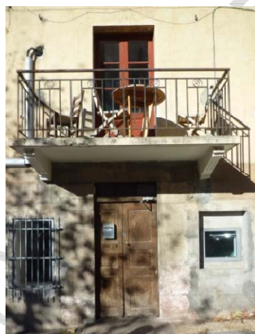
Balcon années 30 en béton sur consoles avec garde corps en fer
