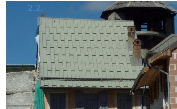
Toiture à deux pans, couverte en bac acier
