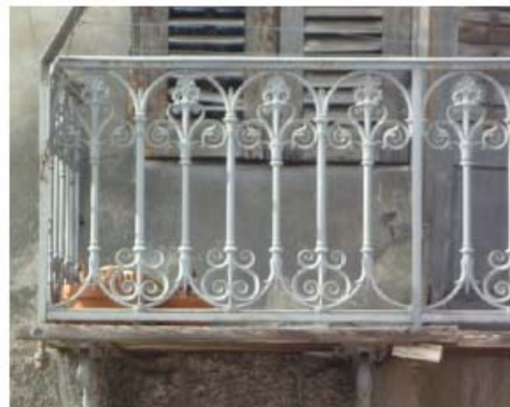
Balcon XIXe en fer sur consoles, garde-corps en fer et fonte
