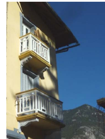
Balcon début XXe en pierre sur consoles, garde-corps en ciment moulé
