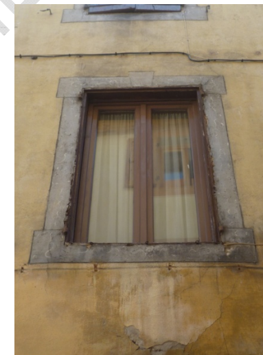
Exemples de décors peints : bossages d'angle , fausse baie et encadrements de baies à crossettes. On note que les encadrements sont soulignés par un liseret ou par un ombrage. Ces décors sont réalisés à l'aide de badigeons de chaux colorés très variés.
