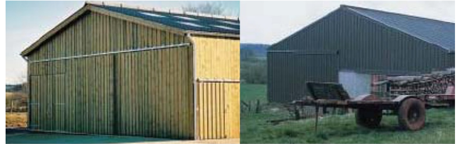
Bardage bois (murs et portes) et bardage métallique de couleur grise
