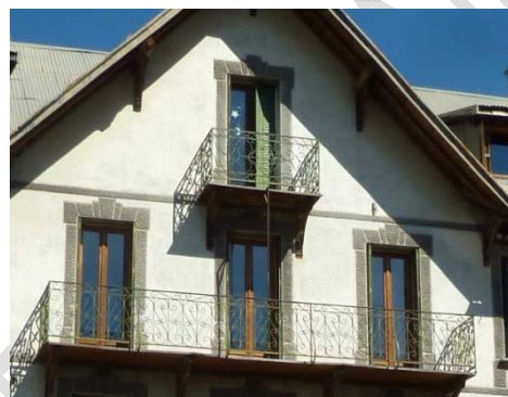
Balcon fin XIXe, début XXe en bois sur consoles, garde-corps en fer
