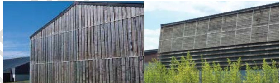
Bardage bois pose verticale et pose horizontale
