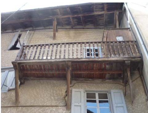
Balcon XVIIIe XIXe en bois sur consoles, garde-corps à balustres en bois
