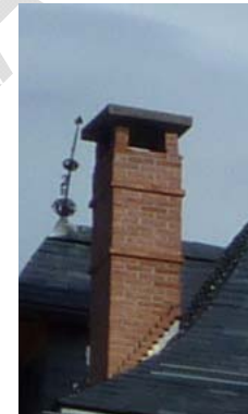
exemples de cheminées en briques et épi de faitage à préserver
