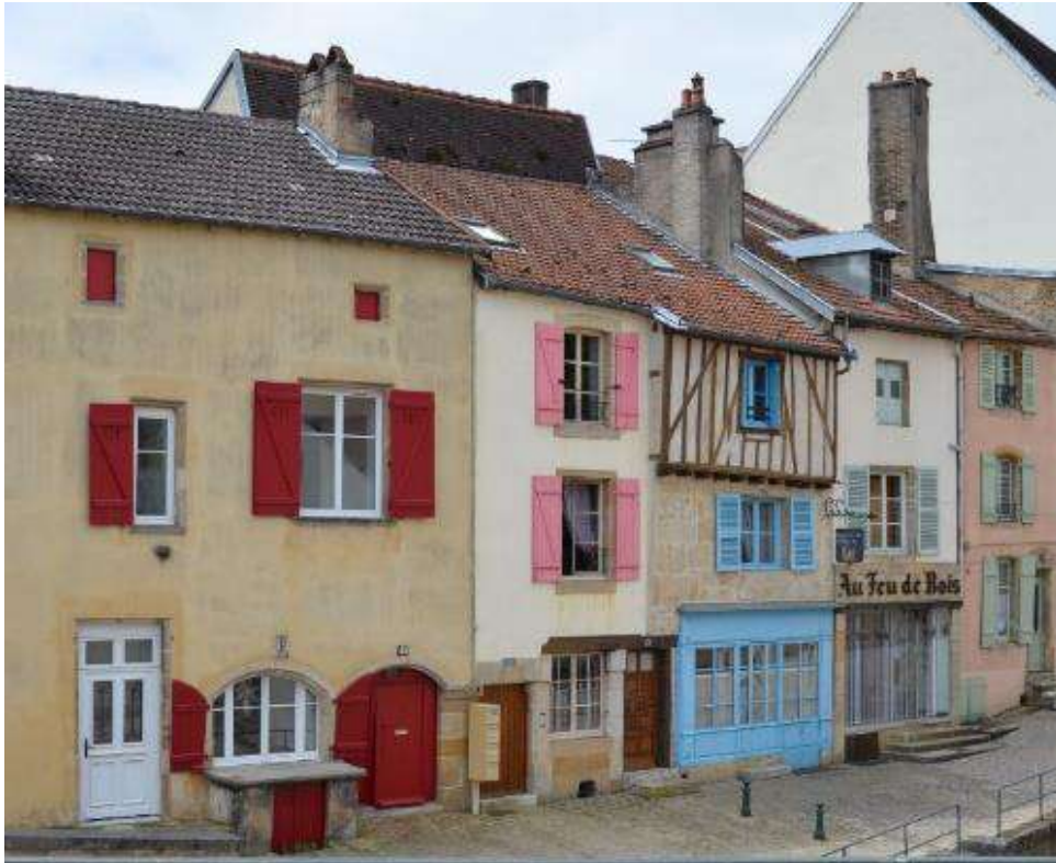
Façades du centre ancien de Langres
