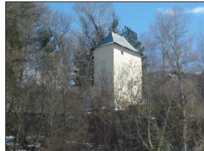
Ancienne tour à l'écart de l'enceinte, qui dépendait vraisemblablement à l'origine du château disparu. Aujourd'hui maison de la nature.
