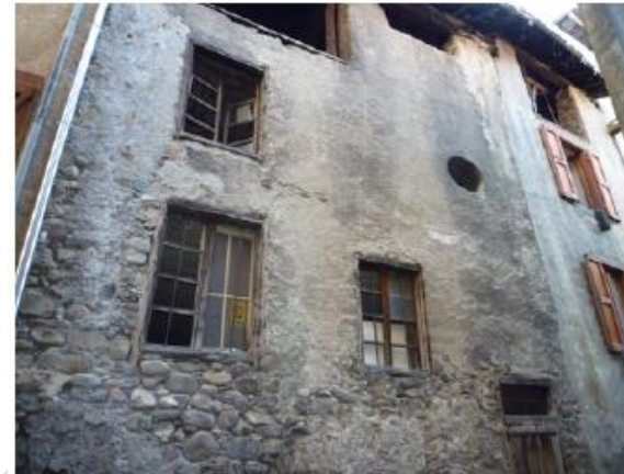
Exemples de parement traditionnel en galets recouvert d'un enduit grossier
