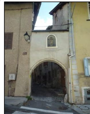
Porte Saint Louis. cliché Atelier MULTIPLE, mars 2016
