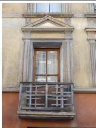
Petit immeuble XIXe du centre-bourg avec décor néoclassique. Fenêtres surmontée d'un fronton triangulaire et encadrée de pilastres triglyphés.
