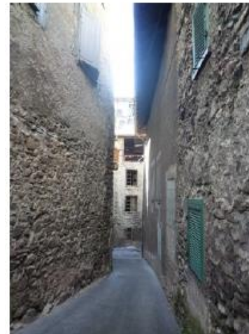
Ruelle avec alternance de façades en galets simplement jointoyés et non enduits et de façades recouvertes d'enduit ciment
