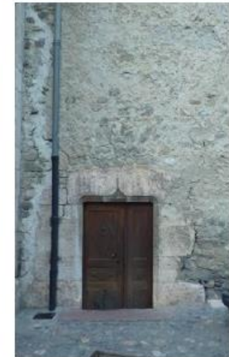
porte avec linteau à accolade (XVIe) en marbre rose
