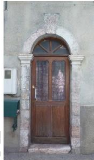
porte plein cintre XVIIe avec encadrement en marbre rose de Guillestre
