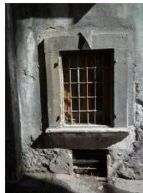
Grille de fenêtre en fer forgé, composée de barreaux de section carré assemblés sur des traverses à trous renflés
