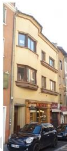
Immeuble années 30, rue Maurice Petsche
