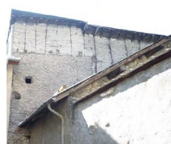
Parties supérieures des murs mitoyens en fond de parcelle construites en pans de bois et remplissage en galets hourdés au mortier de chaux
