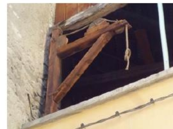
Photo d'une baie de grenier avec son gruatte
