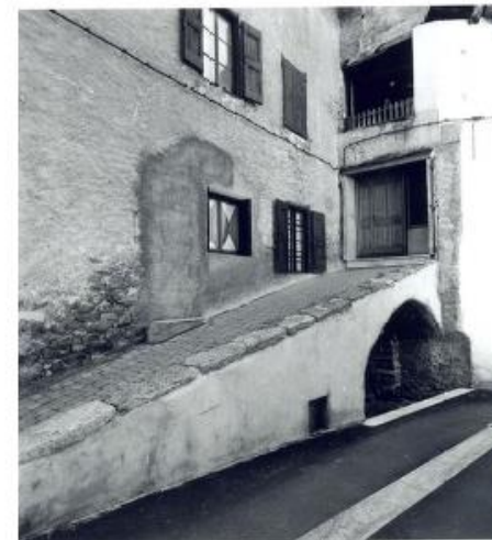
Ponteil de la rue Tournette.
